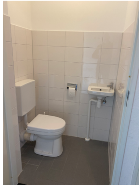
Dit is een vergelijkbaar toilet.
